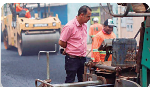
Prefeito Carlinhos do Mangão fiscaliza obras no Município!
